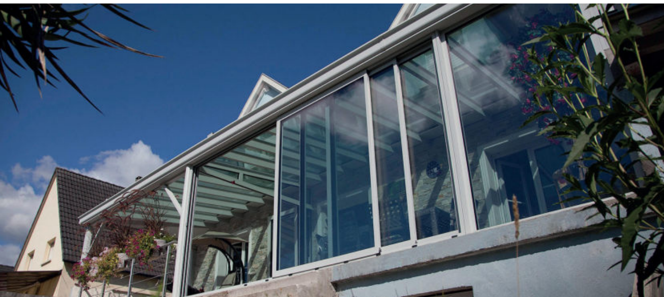
Trois rails et un châssis fixe
